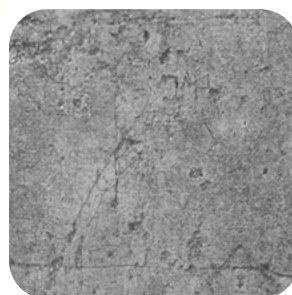
Copertura Piana in Calcestruzzo
